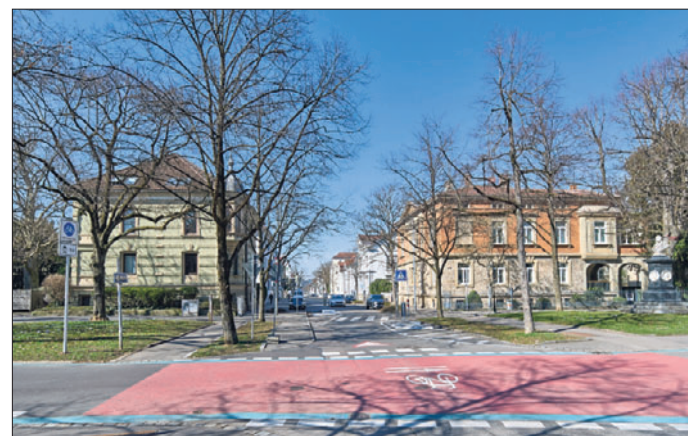
Im Frühjahr startet der Fernwärmeausbau in der Kaiserstraße.
