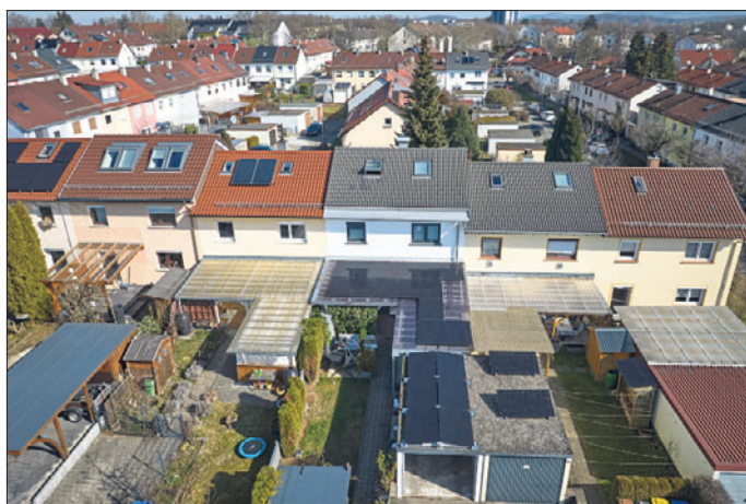
Die Anlage wurde auf der Kunststoffpergola und dem Garagendach von Ivica Vukelic installiert. FOTO: RALPH KOCH/FAIRENERGIE
