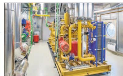
Das neue BHKW-Modul mit 999 kW elektrischer Leistung.
