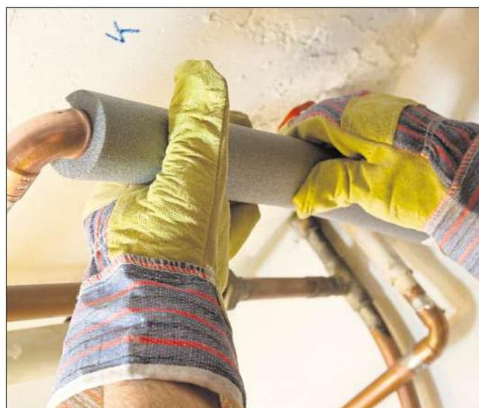
Die Eigentümer eines Altbaus müssen Armaturen, Heizungs- und Wasserrohre, die sich in unbeheizten Räumen befinden, dämmen lassen. FOTO: REMMERS/DPA-TMN
