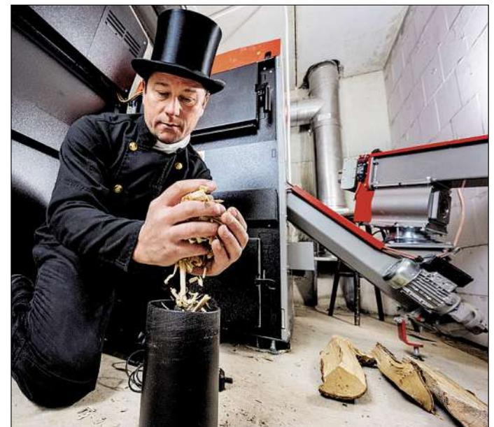
Der Schornsteinfeger kontrolliert die Qualität des Brennstoffs bei einer Hackschnitzelheizung. Solch ein vollautomatisches System spart im Vergleich zu einer Öl- oder Gasheizung große Mengen Kohlendioxid ein. FOTO: DEUTSCHES PELLETINSTITUT/TXN
